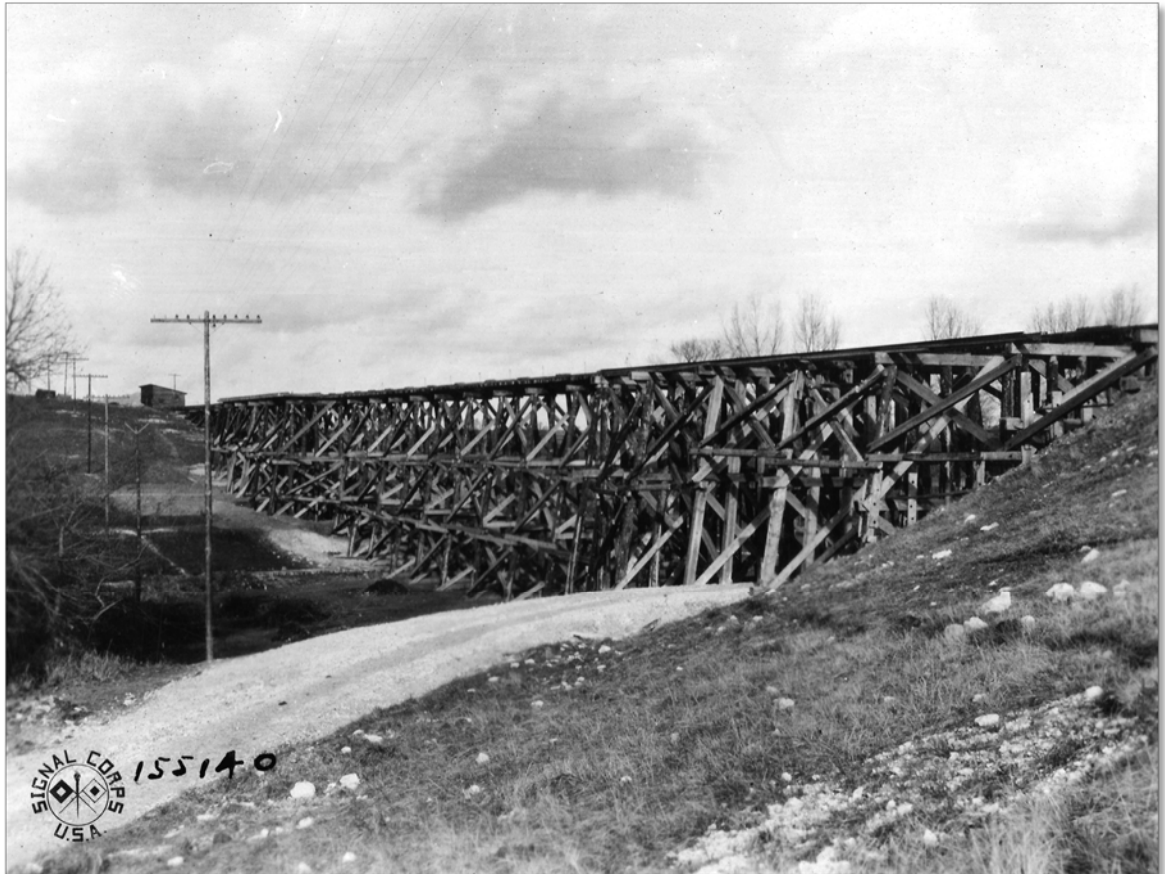
Viaduc ferroviaire La Traverserie, janv. 1919 ( National Archives USA )
