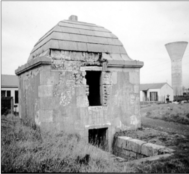
Château d'eau des Granges sur la butte de la Coudre. Le château d'eau actuel se trouve à proximité
