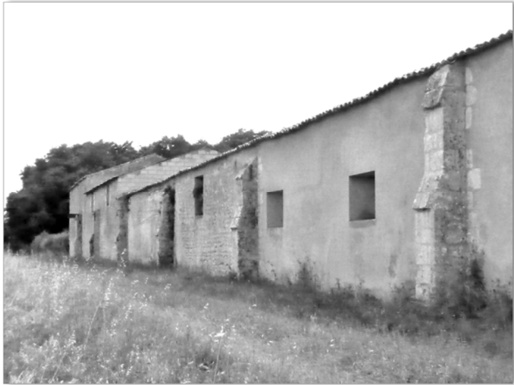
Etat actuel du long mur Est remonté
