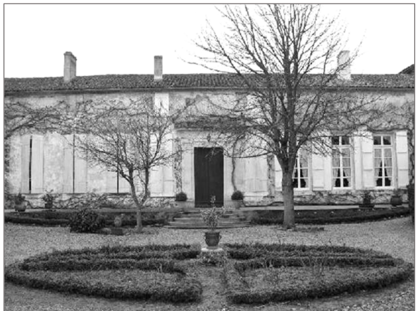
Le château de Loire-les-marais
