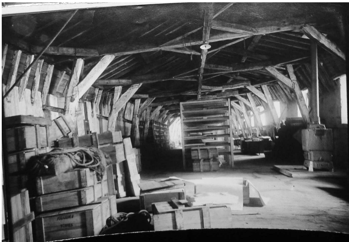
Caisses de matériel et plans entreposés dans les combles de l'ancienne Corderie
