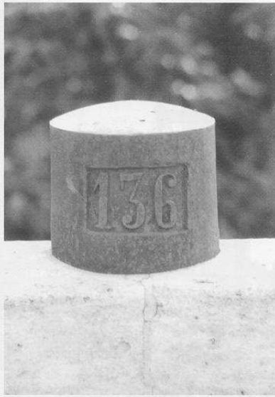
Fig. 11 : Borne métallique sur le parapet du pont de Saint-Porchaire sur la route royale N°137 indiquant le 136 ème kilomètre depuis Bordeaux (Pont de Pierre, rive gauche de la Garonne).
