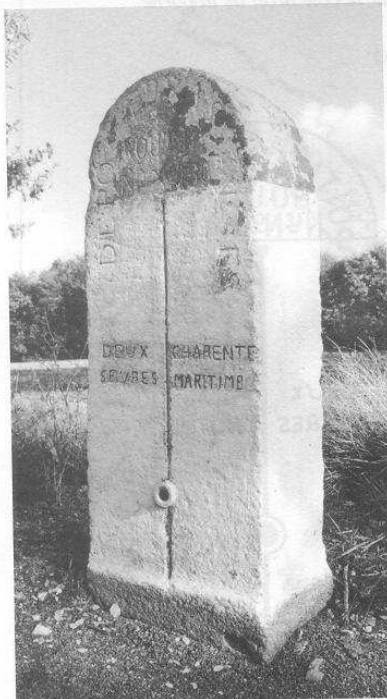
Fig.8 : Borne de limite départementale entre la Charente Inférieure et les Deux-Sèvres sur la route royale n°150 à La Villedieu. ( h=1.57 , l=0.70 , ep=0.37 )
