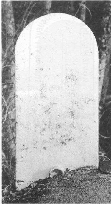
Fig. 4 : Borne de limite départementale entre la Charente Inférieure et la Gironde sur la route royale n°10 bis. ( h=1.39 , l=0.65 , ep=0.31 ) seule la ligne verticale de limite départementale est visible.
