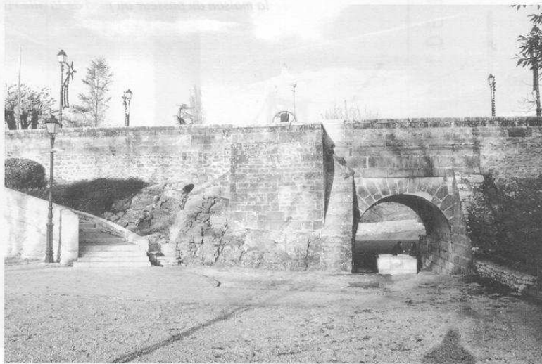
Fig.13 : Vue générale avec la fontaine au milieu du pont.
