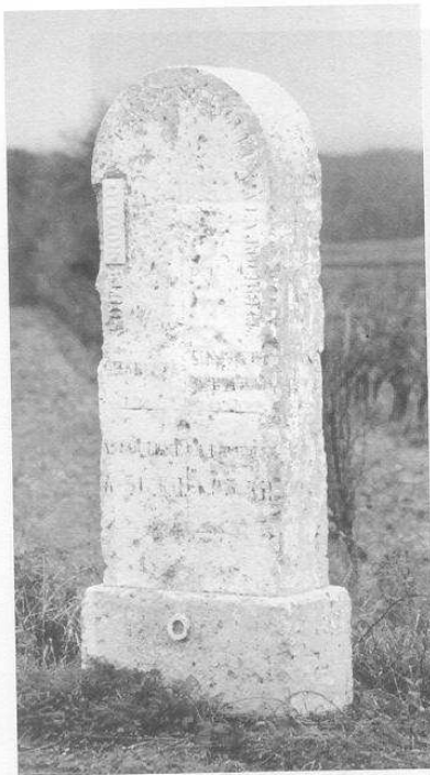
Fig.7 : Borne de limite départementale entre la Charente Inférieure et la Charente sur la route royale n°139 à Neuviq le Château. Remarquer la présence d'une plaque fonte portant le mot « ROYALE » venant modifier le classement initial de la route impériale. ( h=1.60 , l=0.66 , ep=0.30 )
