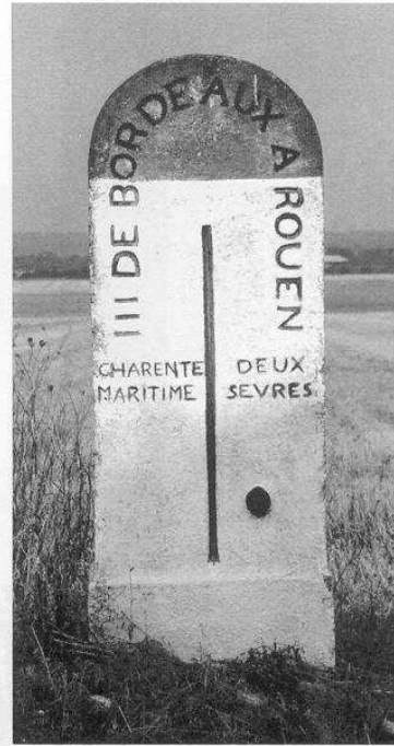
Fig.5 : Borne de limite départementale entre la Charente Inférieure et les Deux-Sèvres sur la route royale n°138 à Villeneuve la Comtesse. ( h=1.54 , l=0.71 , ep=0.38 ) le chiffre « IX » est inscrit sur le côté droit de la borne.
