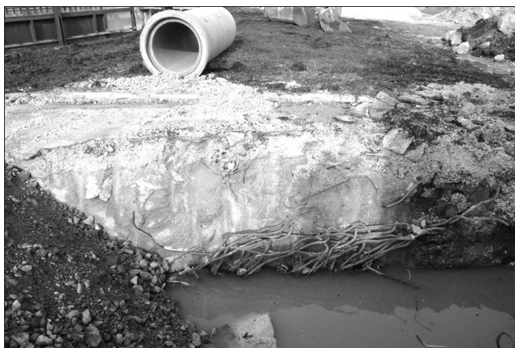
Photo 2 : les pieux de bois retirés du sous-
