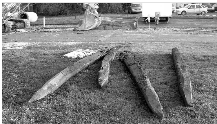
Photo 2 : les pieux de bois retirés du sous-
