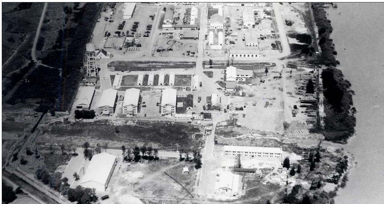
Vue aérienne du site des Fourriers dans les années 1960. Le château d'eau domine l'entrée latérale de l'école. Archives municipales de Rochefort, fonds Bouclaud
