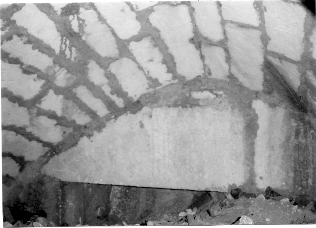
Figure 6 : la dalle du soupirail
