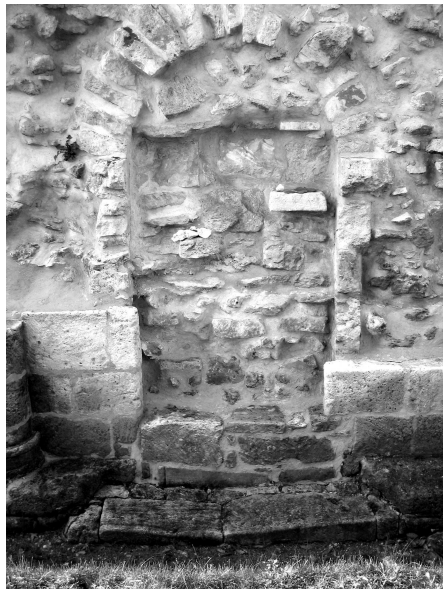
Porte du réfectoire. Vue du nord
