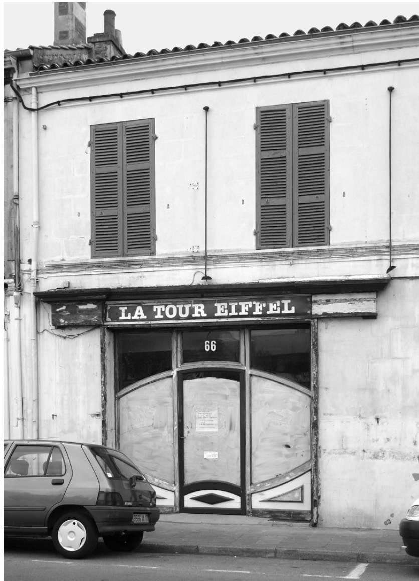
Le graphisme le plus récent du débit de boisson (1961 ?). On notera les suspentes de la verrière aujourd'hui disparue.
